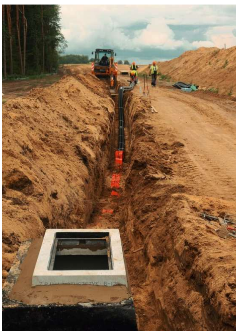
Rys. 34. Zamontowana studzienka kablowa
