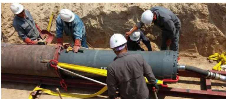
Rys. 28. Przecisk z ubijakiem umieszczonym za rurą stalową
