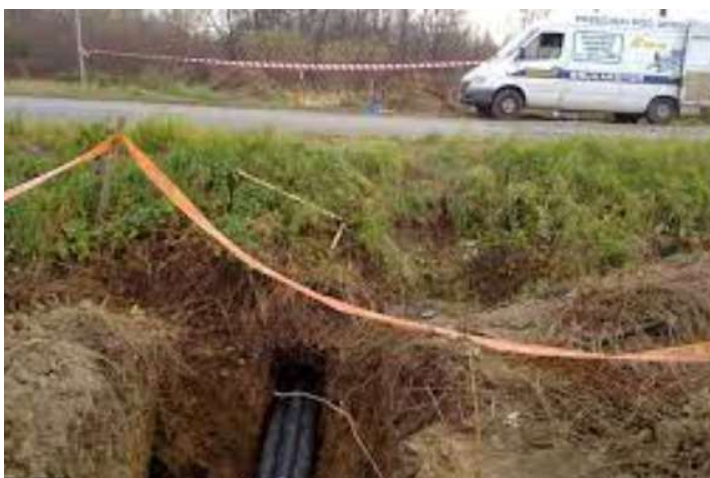
Rys. 31. Kanał kablowy umieszczony metodą przewiertu
