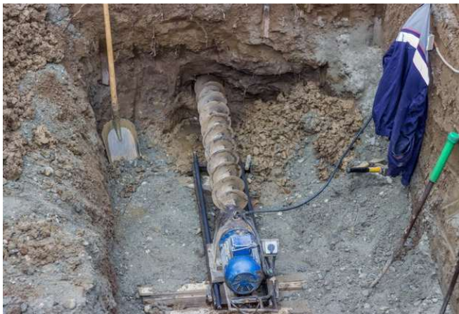
Rys. 30. Wykonywanie przewiertu
